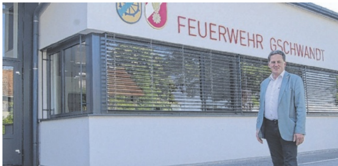
Das Feuerwehrdepot soll mit PV-Anlage und Stromspeicher blackoutfest werden, so Bgm. Fritz Steindl.
