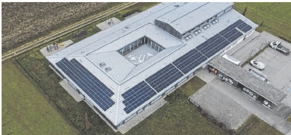
Auf dem Dach der Volksschule sorgt seit Kurzem eine Photovoltaikanlage für nachhaltig erzeugten Strom. Foto: Fa. Beißkammer
