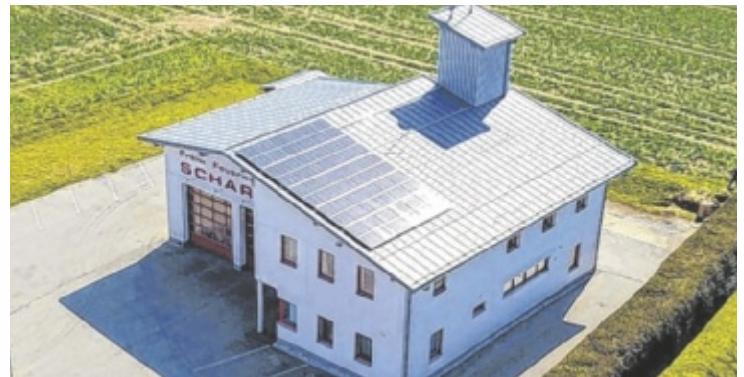
Eine innovative Photovoltaik-Lösung macht die FF Schart im Krisenfall energieautark und spart im Alltag Stromkosten.
