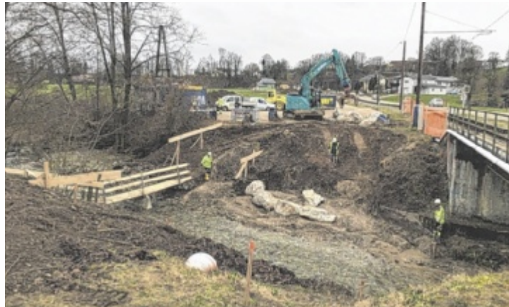
Radweg-Arbeiten in Falkenohren
