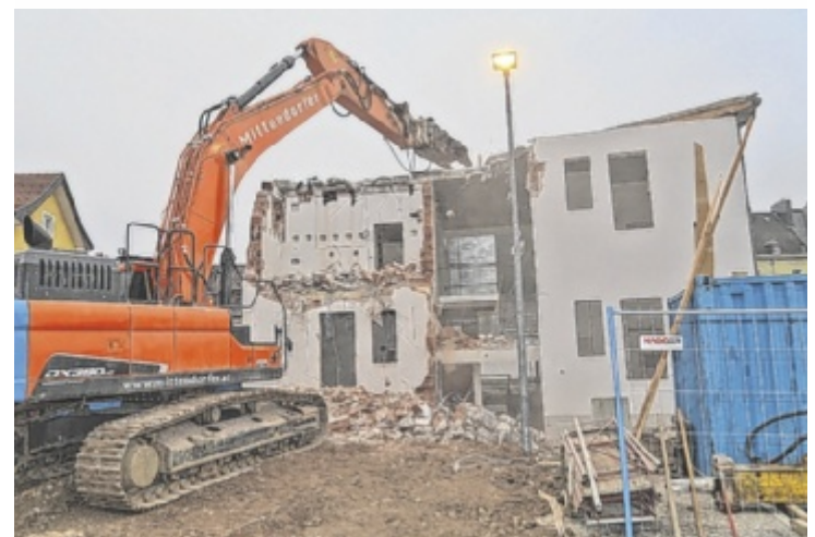
Bagger reißt ehemaliges Volksbank-Gebäude nieder.
