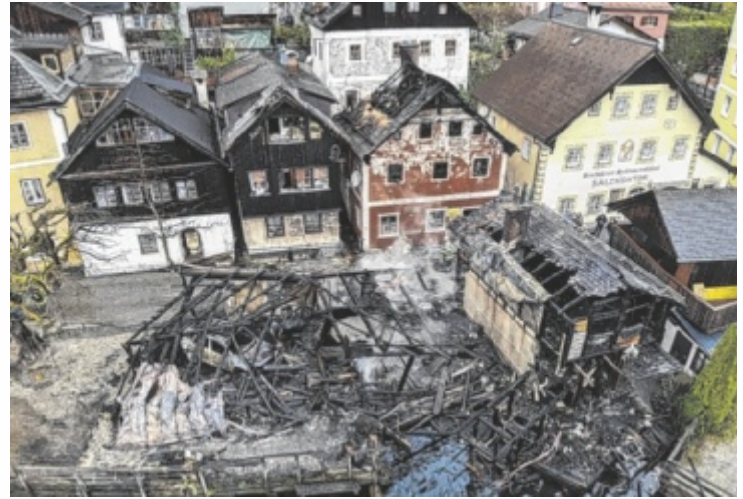
Großbrand zerstörte Gebäude im Weltkulturerbeort Hallstatt.
