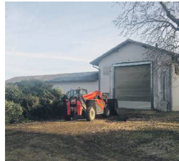
In dieser Anlage passierte der tragische Unfall. Fotos: Peter Sommer
