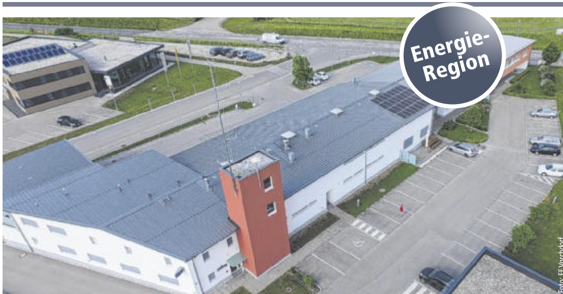
Auch die PV-Anlage auf dem Dach des Vorchdorfer Sicherheitszentrums wurde mit KEM-Unterstützung dimensioniert.
