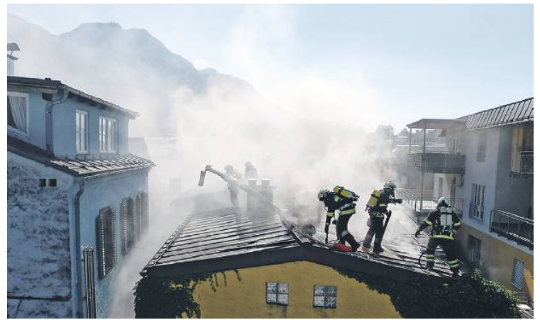
Ein Dachstuhlbrand im dichtbebautem Ischler Ortsgebiet nahe der Esplanade forderte die Einsatzkräfte.
