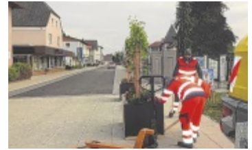
Bauhof-Mitarbeiter bei letzten Verschönerungsarbeiten
