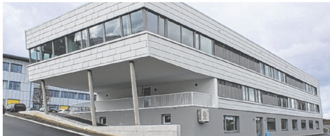
Die moderne Haustechnik (Heizen und Kühlen in einem) für das neue TechnoZ in Gmunden wurde von der GEG installiert.
