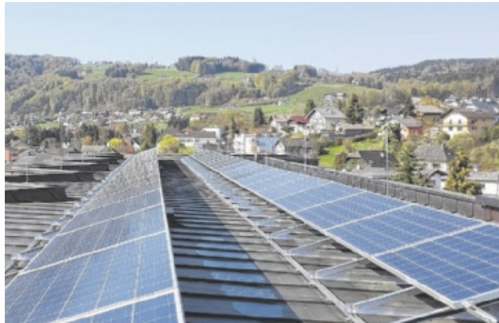
Wie bereits hier am Dach des Altenwohnheims, werden demnächst Photovoltaikanlagen gemeindeeigene Pumpwerke mit Strom versorgen. Foto: Markt-gemeinde
