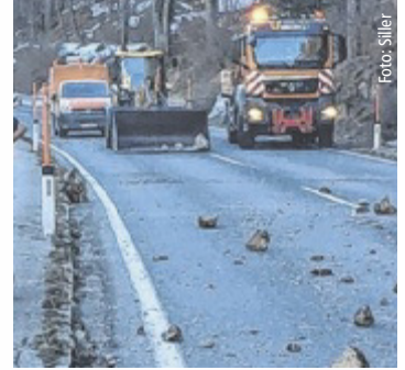
Aufräumarbeiten nach dem Steinschlag
