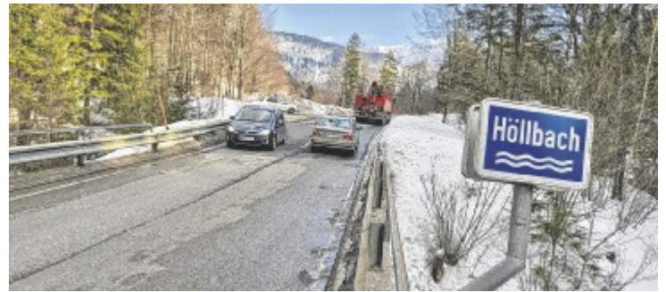
Die Höllbachbrücke entlang der B153 Weißenbacher Straße wird saniert.
