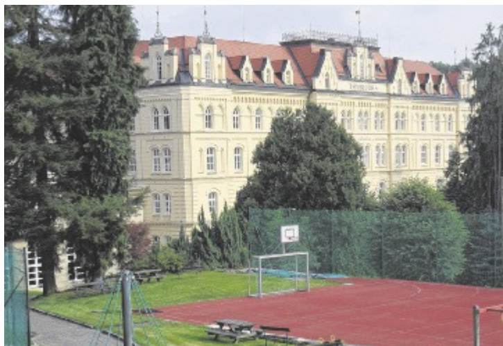
Vorbildlich energieeffiziente Schule: das Pensionat Gmunden/Ort
