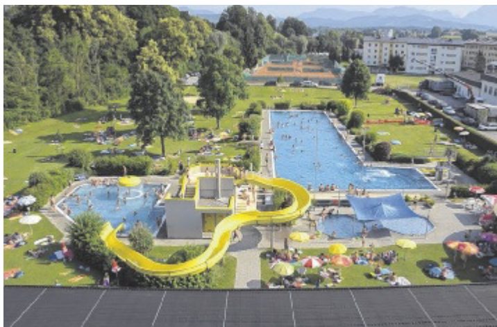
Die Freibäder Laakirchen (im Bild) und Vorchdorf setzen auf Energieeffizienz und sparen insgesamt 68.000 Kilowattstunden Strom im Jahr. Foto: Willi Hitzberger
