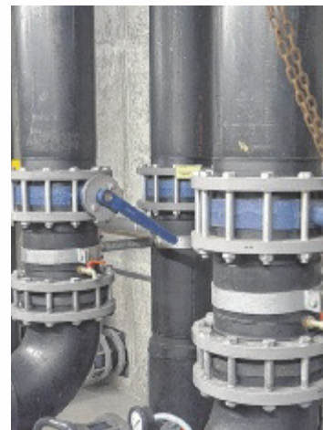
Mittels Drehzahlregelung wurde der Stromverbrauch reduziert. Foto: KEM
